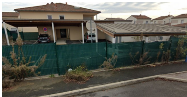
Les herbes débordantes sur les trottoirs
