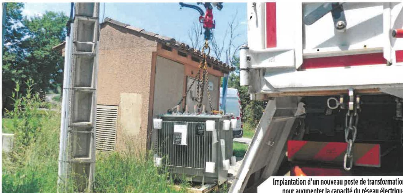
Implantation d'un nouveau poste de transformation pour augmenter la capacité du réseau électrique
