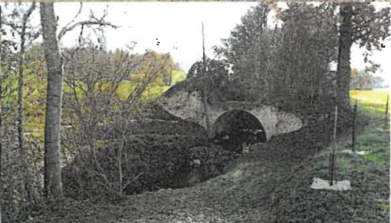
Pont mis en valeur après travaux – dec 2022
