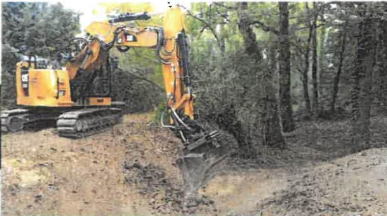
Travaux au niveau du bras du moulin – sept 2022
