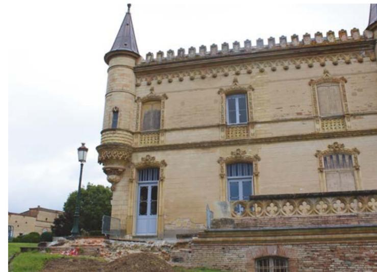
La balustrade et une partie de la terrasse nord-ouest ont été démontées. Des sondages géotechniques ont été réalisés par la société Géotec sur une profondeur de 2 mètres environ. Les sondages intérieurs auront pour objectif d'identifier la présence (ou non) d'une voûte remblayée sous la travée Nord-ouest, au même niveau que le reste du sous-sol, qui pourrait indiquer qu'il s'agit d'une ancienne cave voûtée remblayée ensuite.
