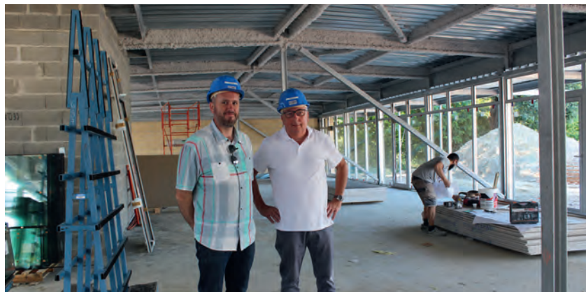
Pascal Paquelet, maire adjoint à la voirie, aux réseaux et aux bâtiments communaux, et Mathieu Lambert, directeur des Services techniques, sur le chantier de la maternelle Arthur Rimbaud
